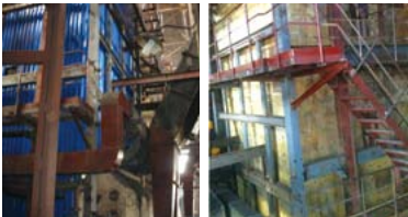
循环流化床锅炉施工现场
