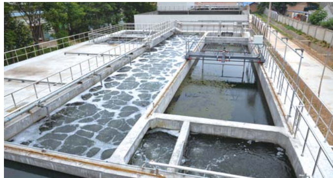
污水处理设施
