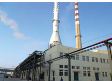
华锦脱硝项目外景
